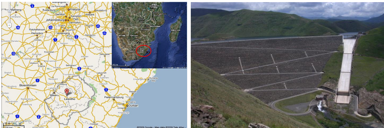
Figure 4.31 : Localisation et Vue aval du barrage de Mohale
