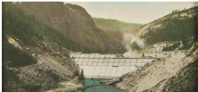
Figure 1.4 : Vue du barrage de Salt Springs
