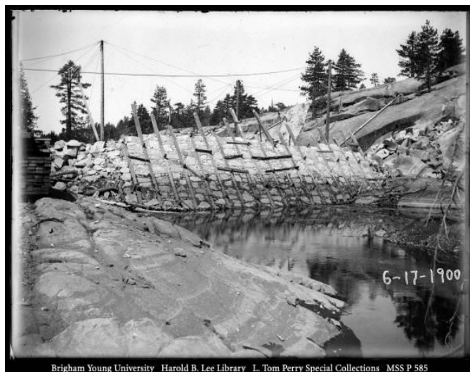
Figure 1.2 : Vue du barrage de Meadow lake (en phase de construction)
