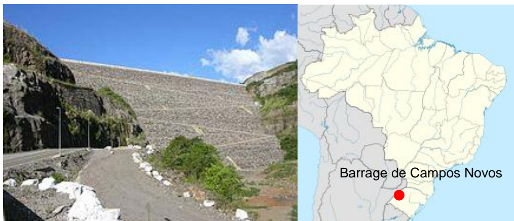
Figure 1.26 : Barrage de Campos Novos (Gauche : Vue aval ; Droite : Lieu du barrage)
