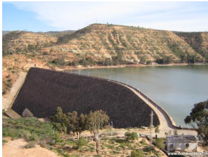
Figure 1.7 : Vue du barrage de Bou-Hanifia [Laigle, 2010]
